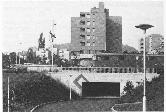
Personenunterführung Riedhaldenstrasse. Nordausgang
