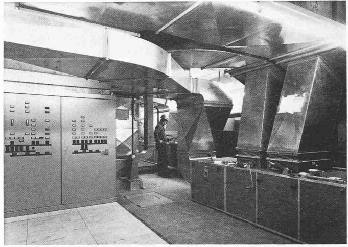
Blick in eine Lüftungsanlage
