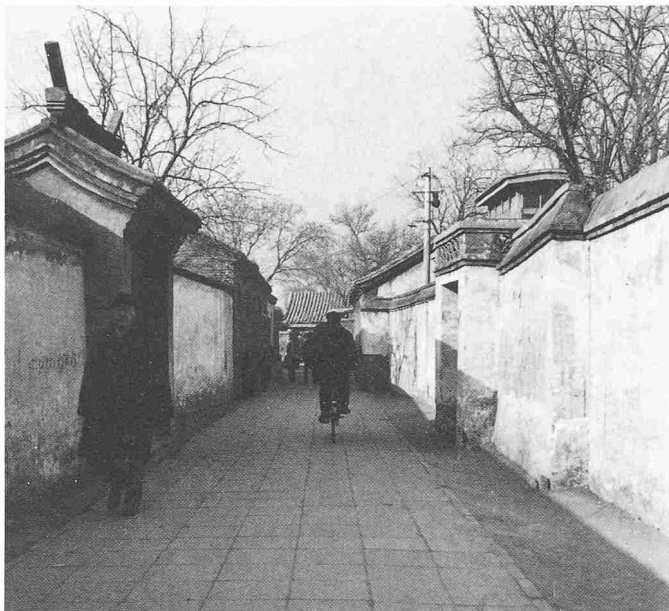
Erschliessungsstrasse mit Eingängen zu den Hofhäusern in Peking
