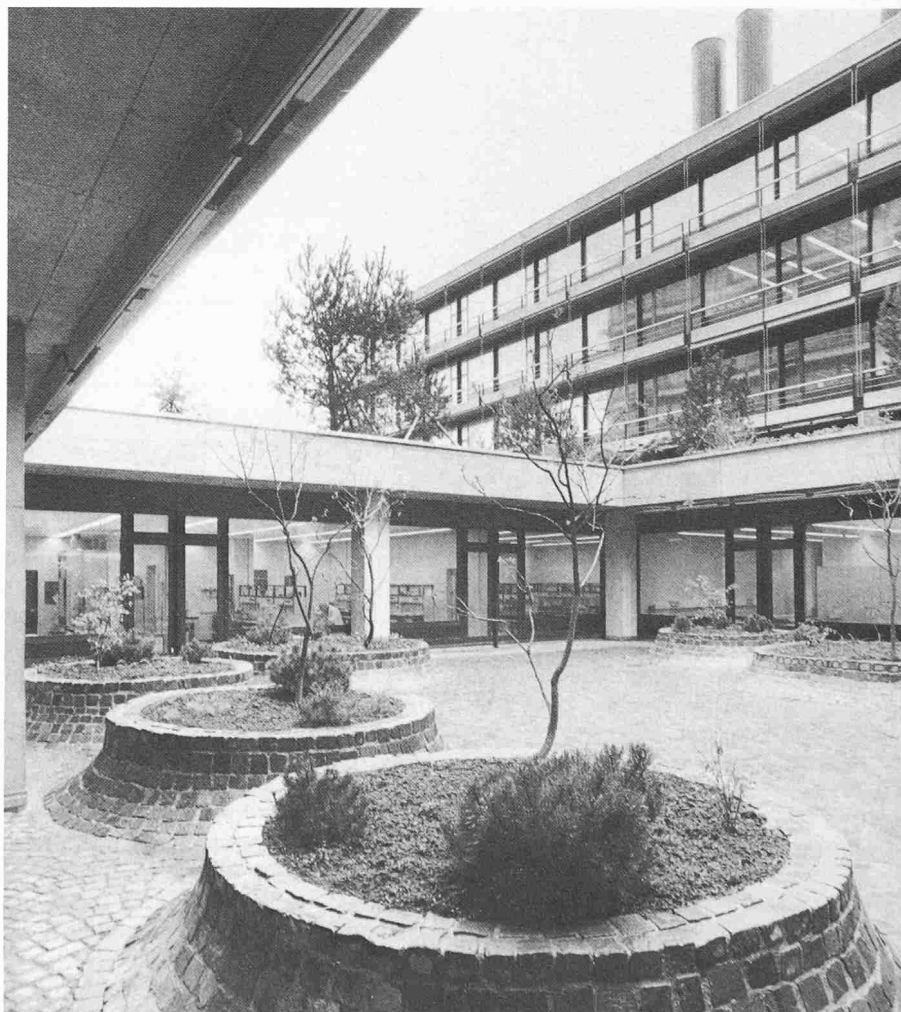
Blick in einen Innenhof zwischen den Labortrakten
