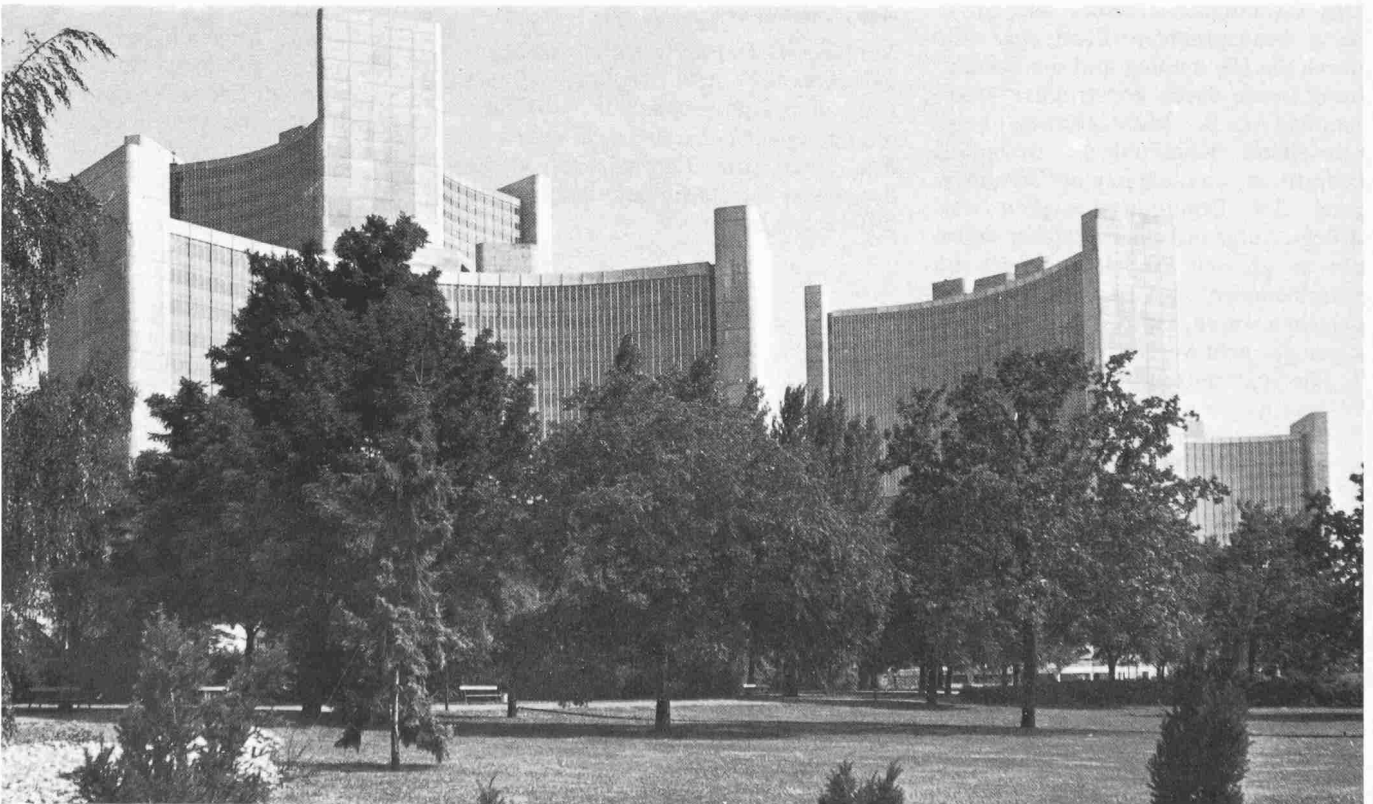
Blick von Süden durch die Parkanlage auf den Baukomplex
