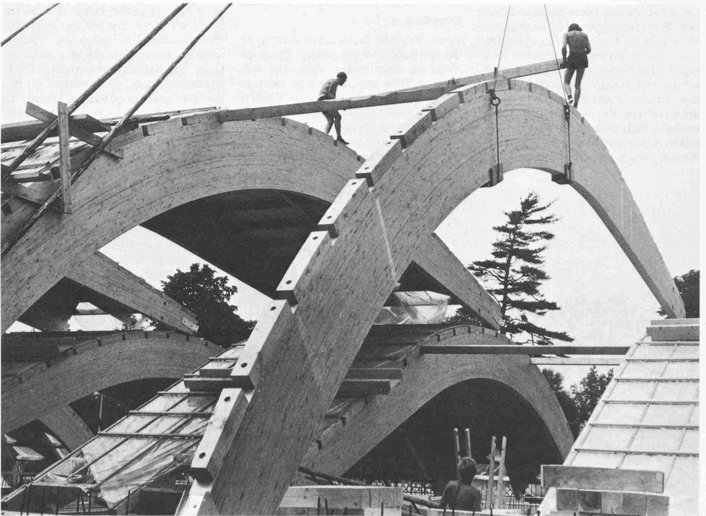
Montage einer Salzlagerhalle in Schweizerhalle, 1970. Stützweite 34 m. (Foto LIGNUM)
