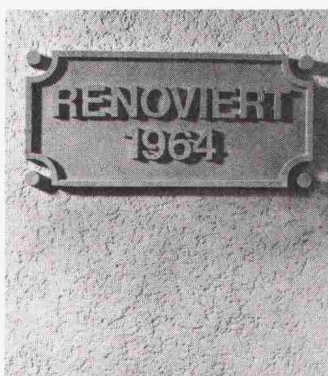
Der Wärmedämmputz hat sich seit über 14 Jahren bewährt
