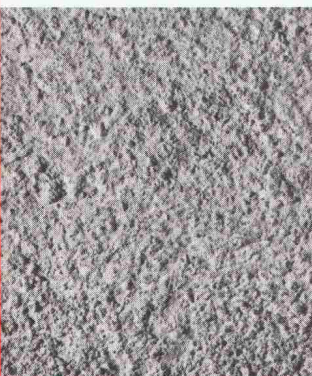
Zementmörtelanwurf (ohne Kunststoffe)
