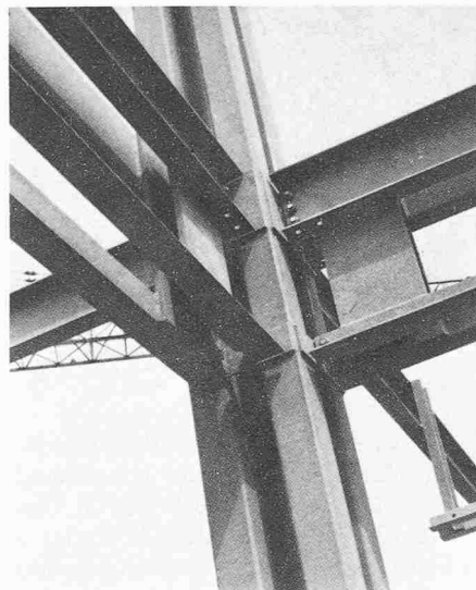
Detailansichten Stützenanschlüsse
