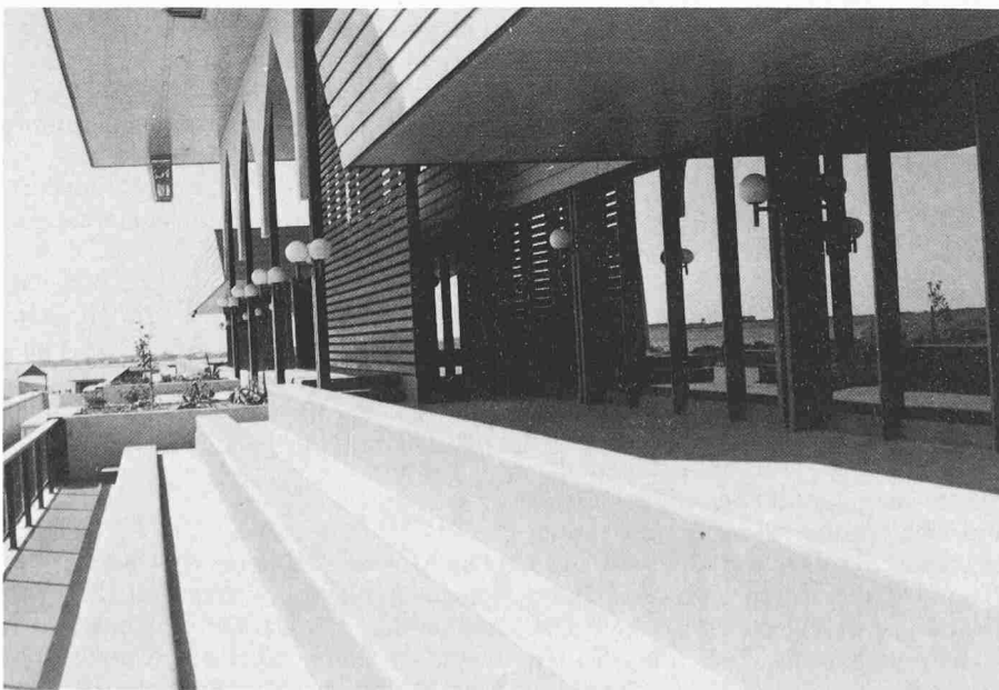
Fassadenausschnitt und Tribüne
