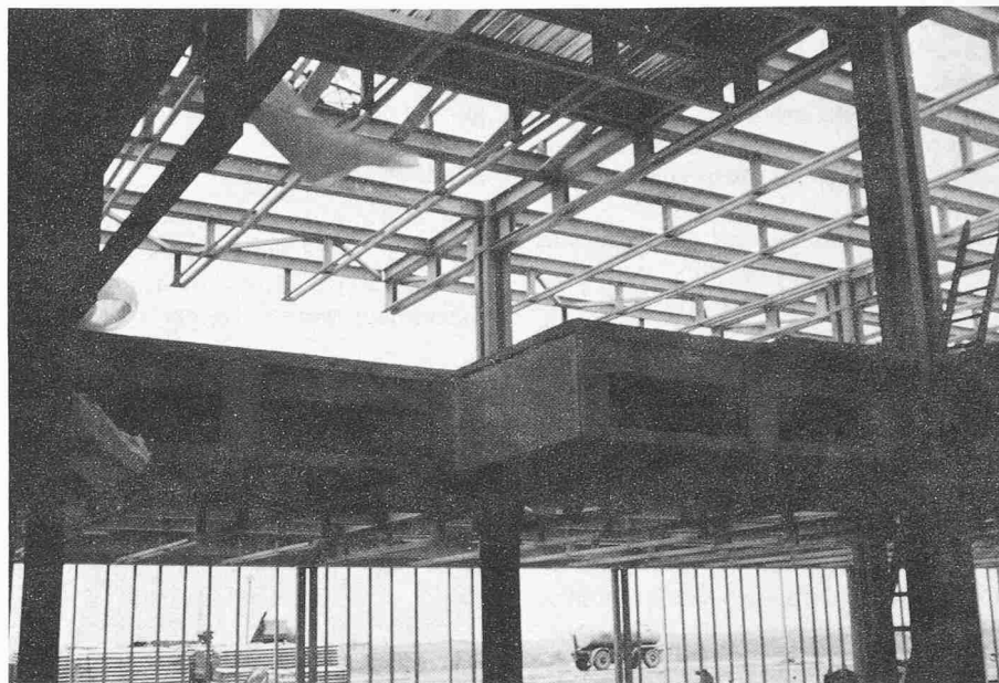
Detail bei Treppenausschnitt mit Spezial-Vierendeelträger
