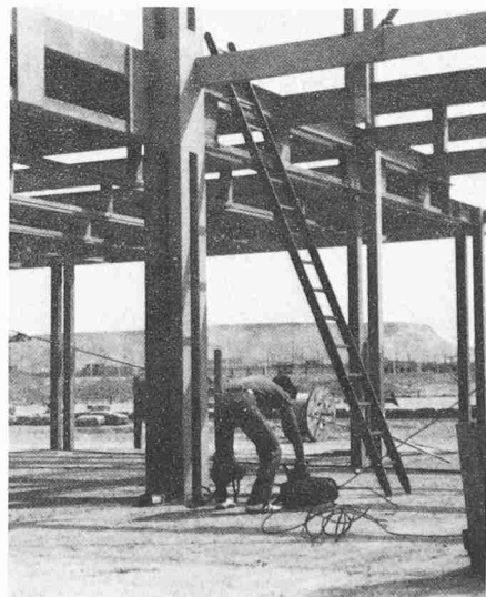
Montage der Deckenelemente
