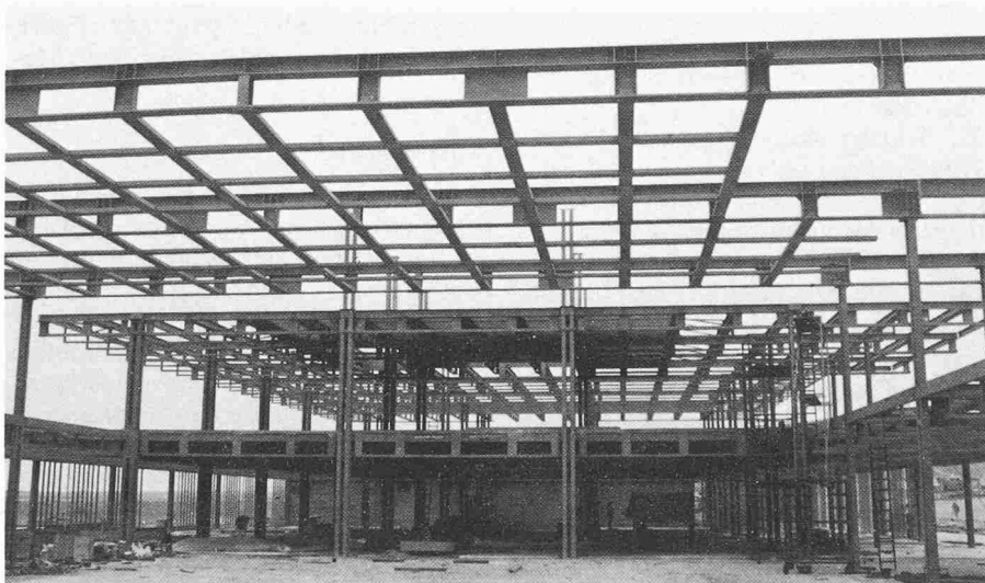
Blick aus der Turnhalle gegen zweistöckigen Gebäudeteil
