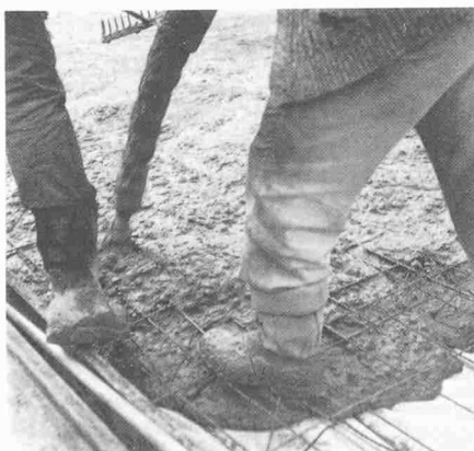
Bild 6-8. Eine ungeeignete Zusammensetzung (Sieblinie) des Ausgangsbetons lässt sich nicht kompensieren durch eine höhere Dosierung des Zusatzmittels!
