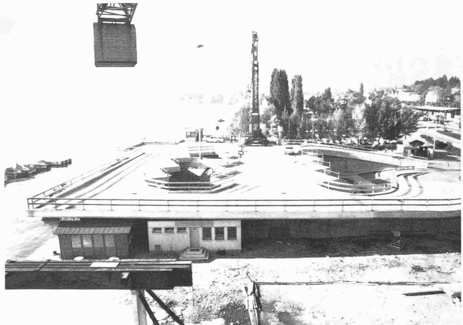
Bild 2. Verladerrampe. Sicht nordwärts gegen die Stadt Zürich
