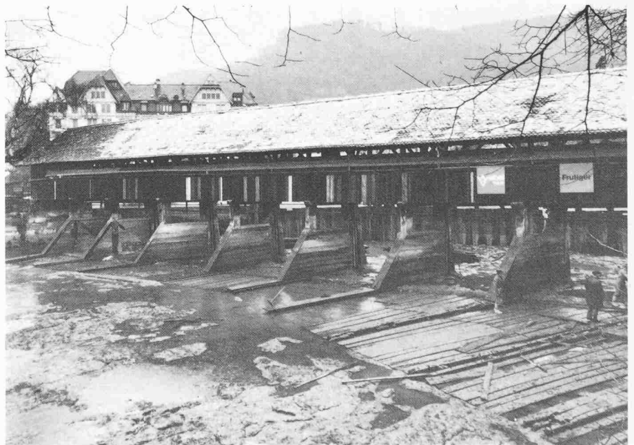
Zustand der Schleuse unmittelbar nach der Trockenlegung
