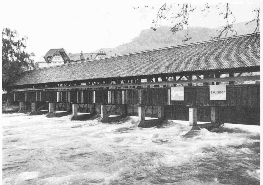
Mitte Mai, knapp nach der Inbetriebnahme der erneuerten Schleuse, rauscht das erste 300 \text{ m}^3/\text{s} Hochwasser durch die äussere Aare
