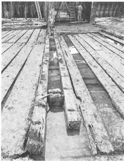
Fallboden der Öffnungen 2 und 3
