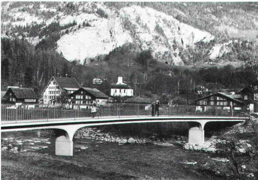
Aaresteg in Innertkirchen, erbaut 1951. BBRV-Spannkabel beweisen ihre Dauerhaftigkeit seit nahezu 30 Jahren in 6000 Bauwerken in der Schweiz und in Zehntausenden auf allen Kontinenten.
