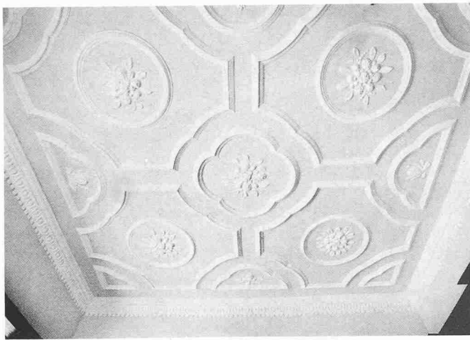
Prunkzimmer im Obergeschoss: mit Früchten bereicherte Stuckdecke
