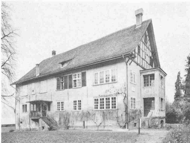
Südost-Ansicht vor der Restaurierung
