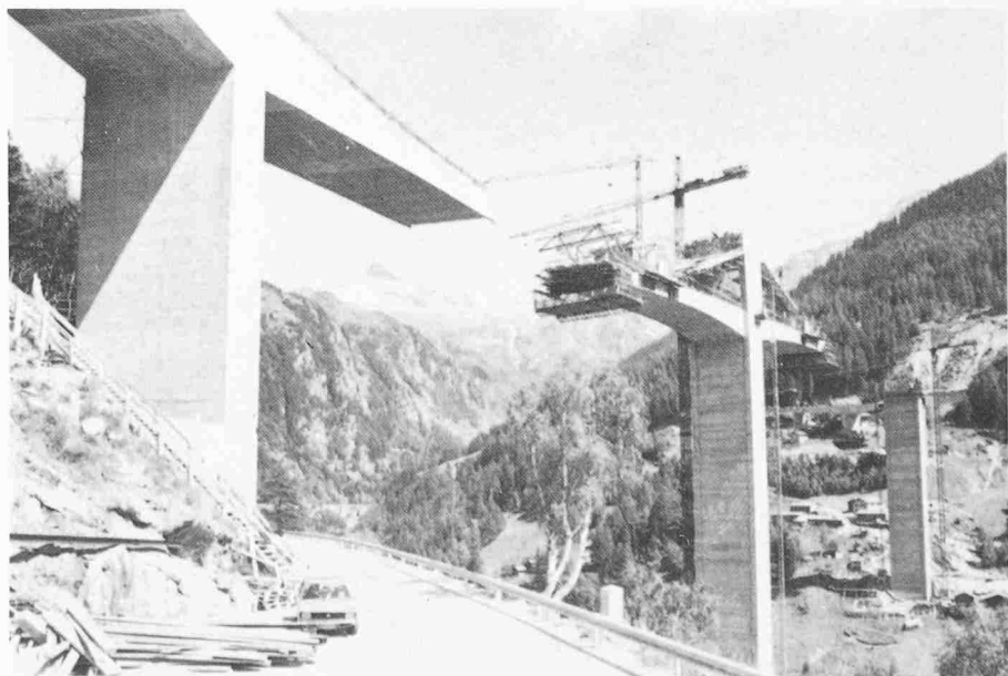
Bild 5. Übersicht über die Baustelle von der rechten Talseite aus gesehen
