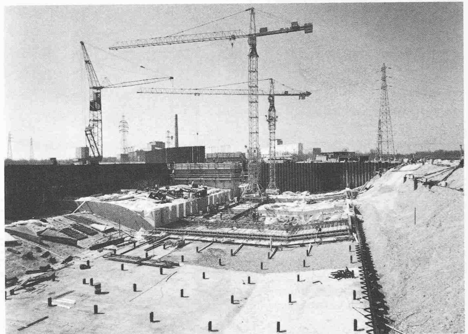
Bild 4. Blick in die Baugrube des 1. Bauabschnittes mit der Wehrsohle
