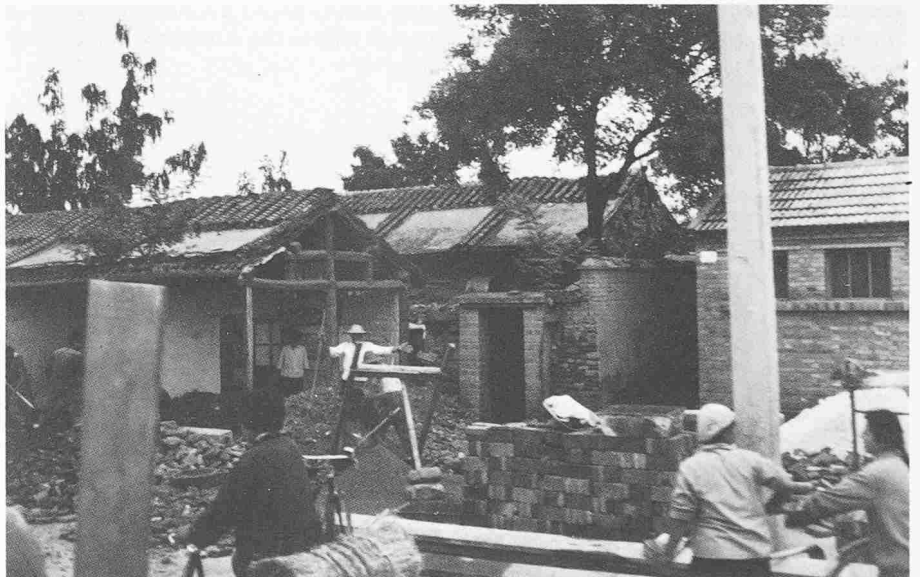
Bild 6. Beschädigte traditionelle Häuser in Peking, Aug. 1976 (Photo J.-P. Voiret)
