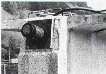
Vorfabrizierter Träger mit beweglicher Verankerung Typ A 2350
