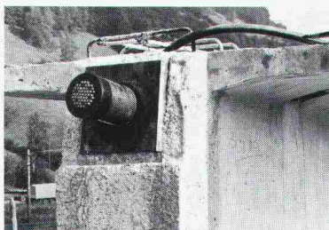
Vorfabrizierter Träger mit beweglicher Verankerung Typ A 2350
