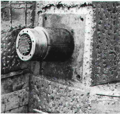
Brückenträger mit beweglicher Verankerung Typ M 4600
