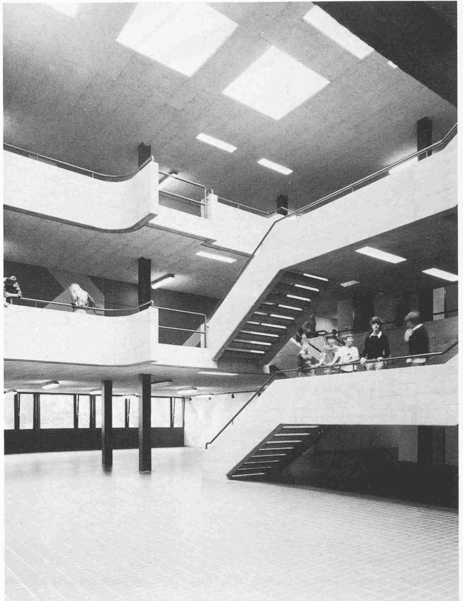
Die dreigeschossige zentrale Treppenhalle mit Raumreserve im Erdgeschoss für späteren Ausbau. Farbige Wandgestaltung von Konrad Hofer, Basel
