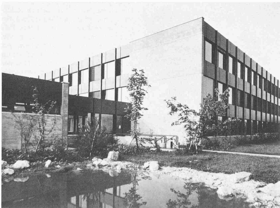
Nordwestecke des Klassentraktes mit Verbindungsteil zur Sporthalle
