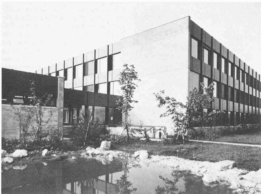
Nordwestecke des Klassentraktes mit Verbindungsteil zur Sporthalle
