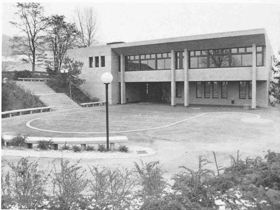
Ansicht von Westen, Pausenplatz
