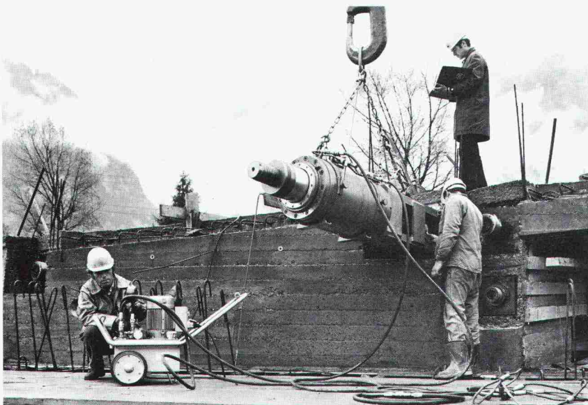
Spann- und Injektionsarbeiten werden durch Bauführer der STAHLTON AG überwacht, kontrolliert und protokolliert.
