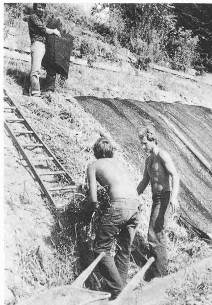
Bild 19. Nagelfluh Oberdiessbach. Über einer dicken Strohschicht als Mulch werden Strukturmatte ausgerollt. (Deckbauweise)
