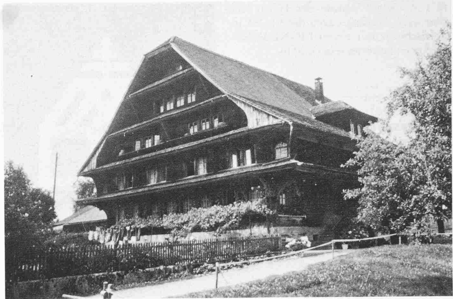
Bild 10. Konstruktiver Holzschutz an einem 200-jährigen Luzerner Bauernhaus
