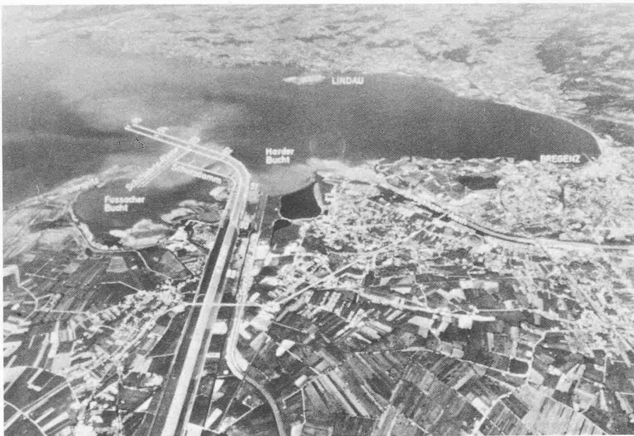
Bild 9. Einmündung des Rheins in den Bodensee. Durch den Bau von Vorstreckungsdämmen soll der Rhein nach Westen abgelenkt werden, damit sich die Schwebstoffe in grösseren Seetiefen als bisher absetzen
