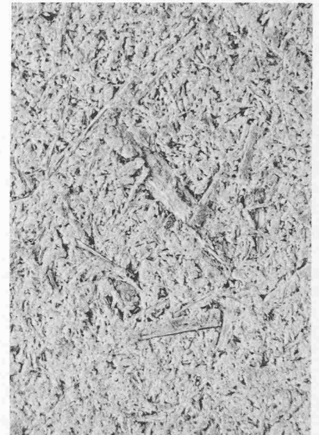
Bild 7. Nahaufnahme der Oberflächenstruktur (3fache Vergrößerung) bei den Schallschutzwänden (Bild 6, Seite ?). Die Platten weisen keine Oberflächenbehandlung (Anstrich, Verputz usw.) auf
