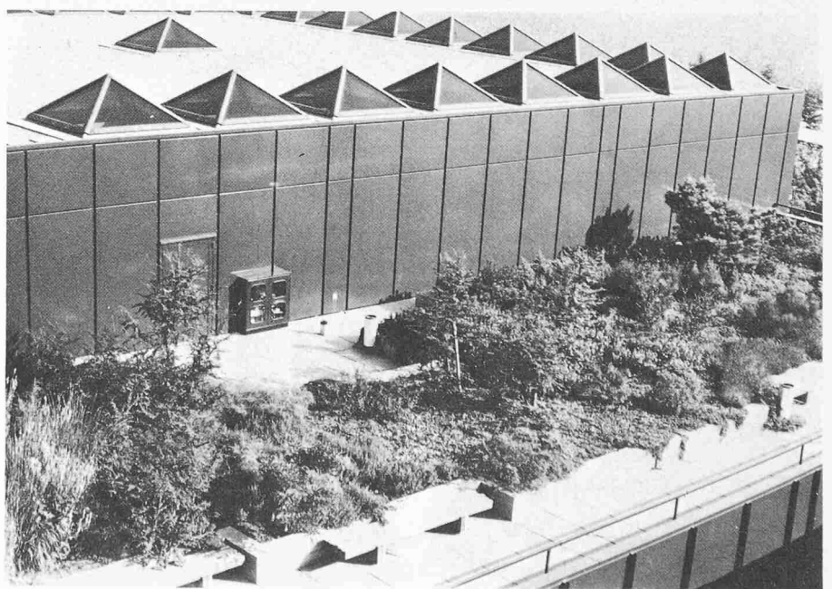
Bild 2. Teil des Dachgartens, Steuerschrank an der Bibliotheksfassade
