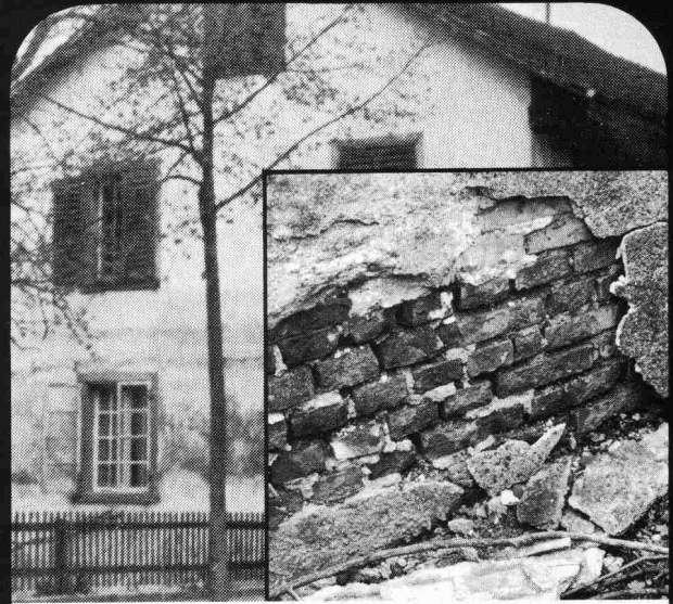
Renescan-Injektionen gegen aufsteigende Feuchtigkeit
