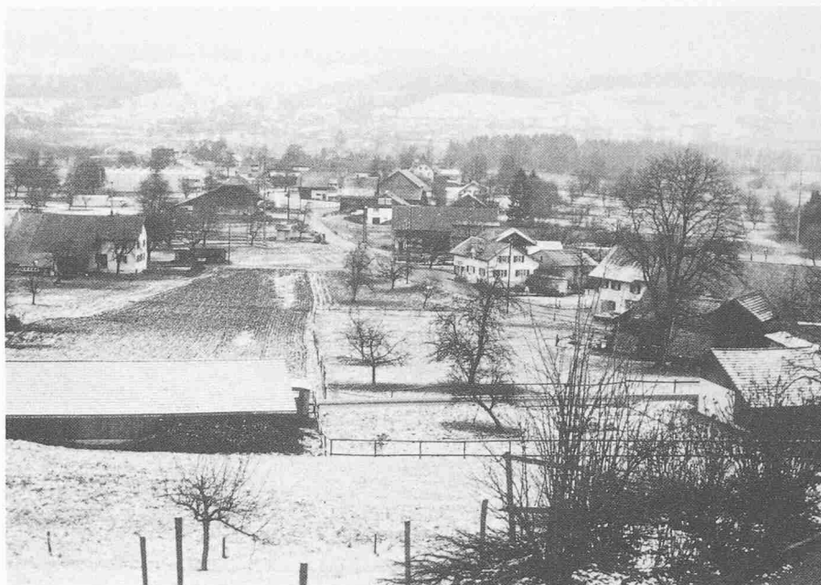
Rottenschwil. Blick vom westlichen Talhang (Rebberg)
