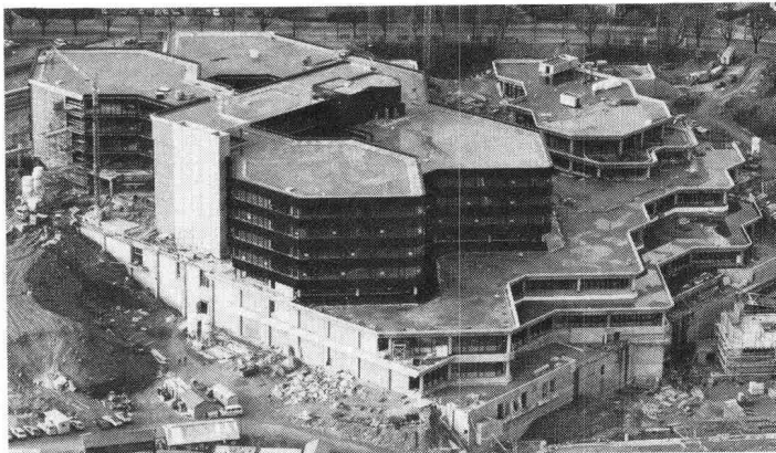
SKA-Neubau Uetlihof Zürich 28'000 m 2 Sarnafil
