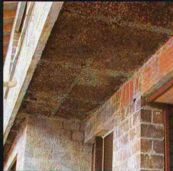
Kork in die Schalung gelegt
