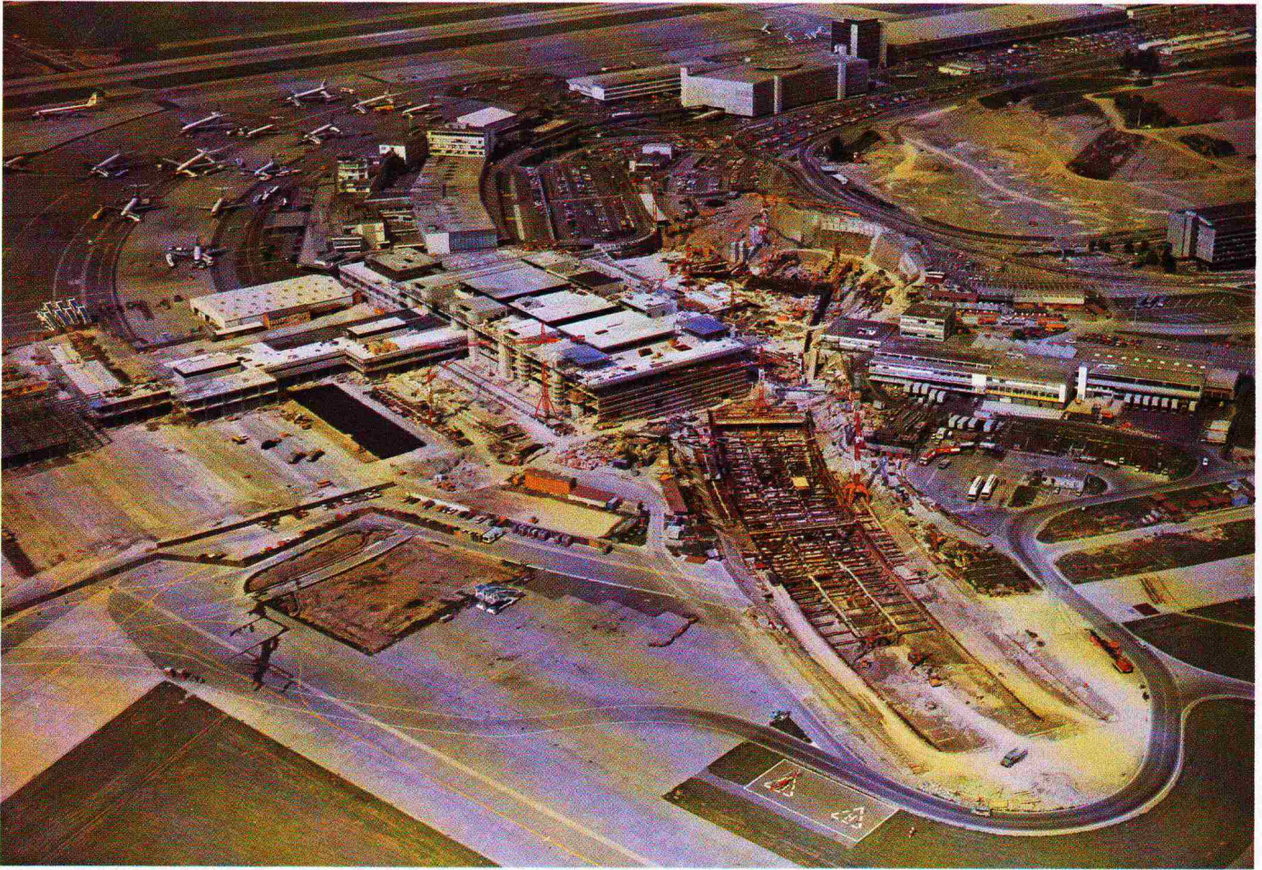
Bild 5. Blick von Südwesten auf den Flughafenbahnhof (Bauzustand: Mai 1974)
