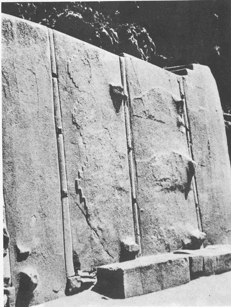
Die Monolithen von Ollantaytambo. Auf dem Gipfel des Befestigungswerkes von Ollantaytambo befindet sich das erstaunlichste Zeugnis inkaischer Steinhauerarbeit. Es sind sechs riesige behauene Steinblöcke, die eine Art «Wand» bilden. Die Monolithen bestehen aus einem blassrötlichen Granit, der eben behauen wurde, mit einzelnen vorstehenden Buckeln. Die Blöcke erreichen Höhen bis zu 4,05 m und Breiten bis zu 2,2 m
