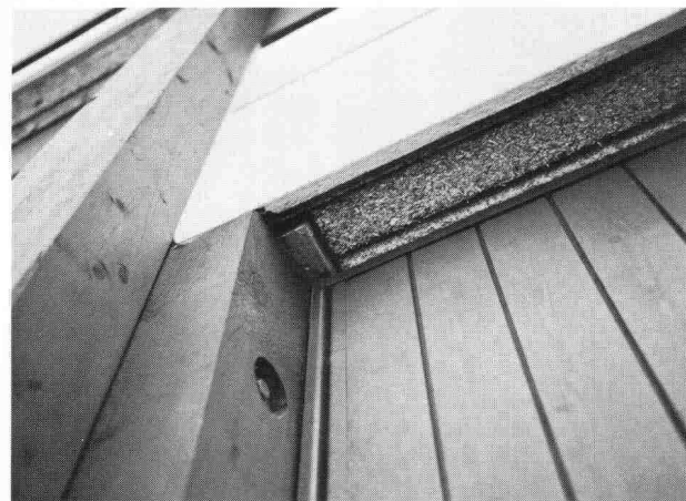
Detail Mehrzweckhalle, Haag SG
