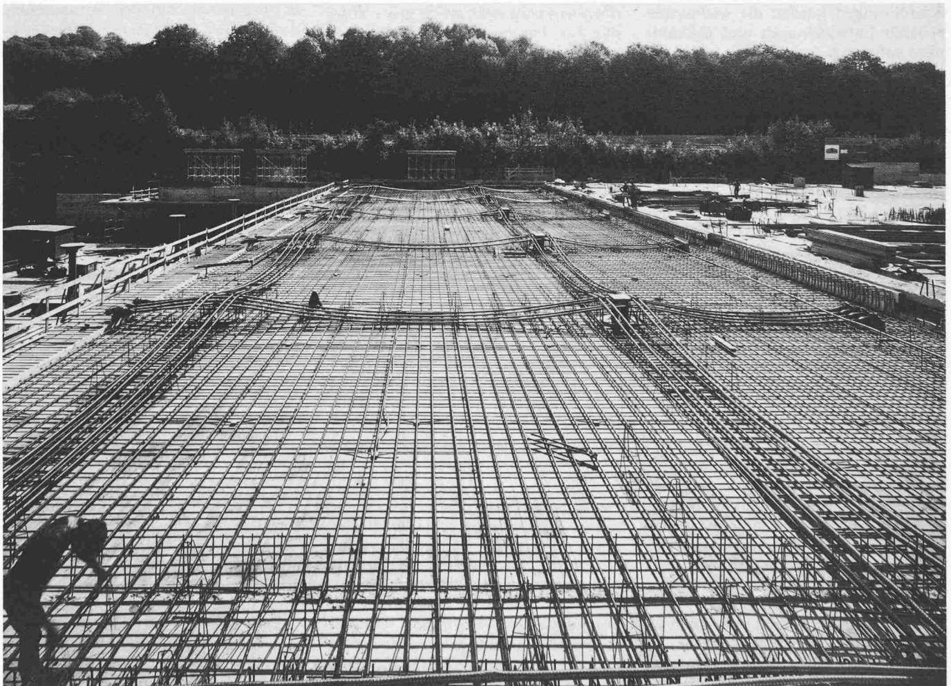
Bild 1. Stützstreifen-Vorspannung (obere Bewehrung noch nicht verlegt)
