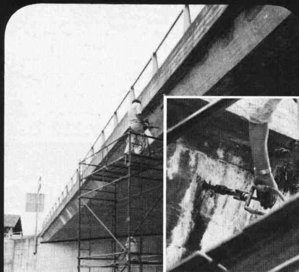
Risse in Betonbauwerken Abdichtung mit Renesco-Flexin-Injektionen
