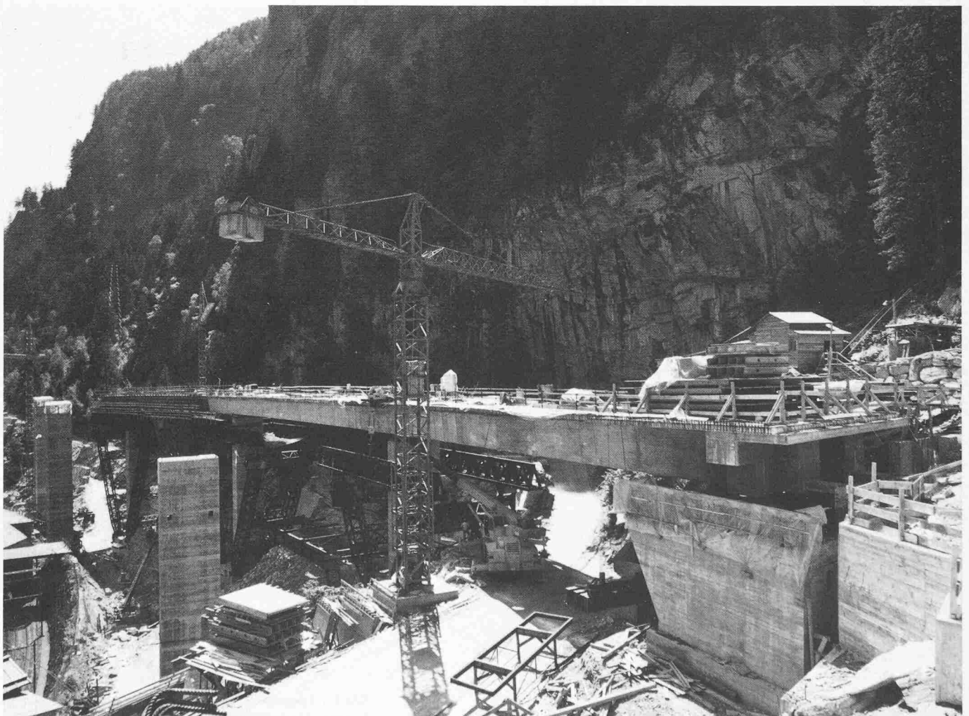
Stand der Arbeiten am 23. Juli 1980
