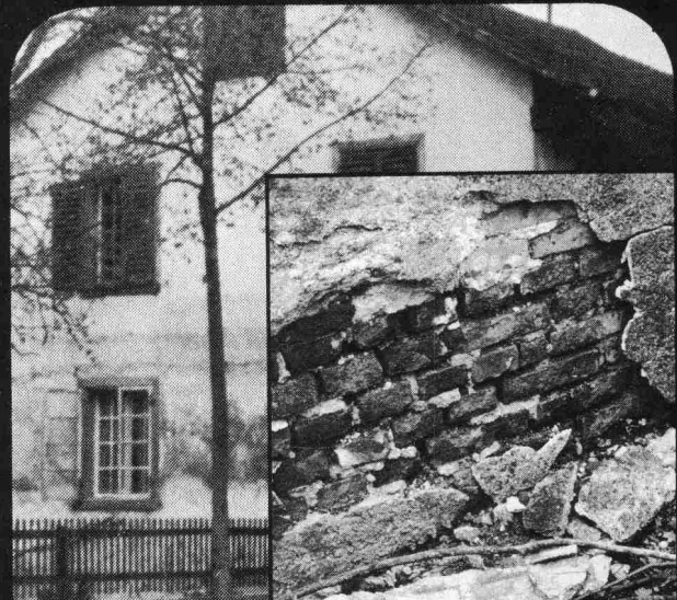
Renescan-Injektionen gegen aufsteigende Feuchtigkeit
