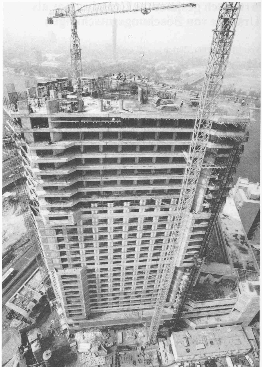
Bild 6. Betonarbeiten im 26. Geschoss. Im Hintergrund Nil und Cairo-Tower
