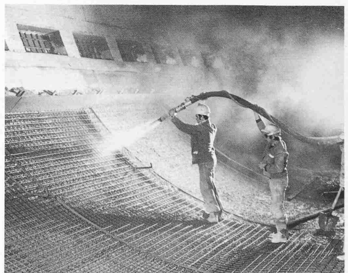
Bild 4. Los West: Erstellen des Spritzbetonsohlgewölbes
