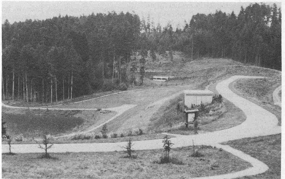
Hochwasserrückhaltebecken Götzenbach. 1,7 Mio m 3 . Kocher-Lein-Verbund.
