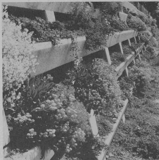
Detail aus einer bepflanzten Stützmauer
