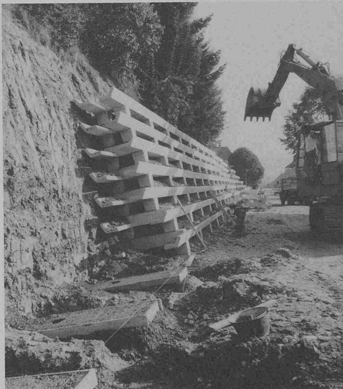
Bau einer Stützmauer an der Staatsstrasse Walkringen (BE)
