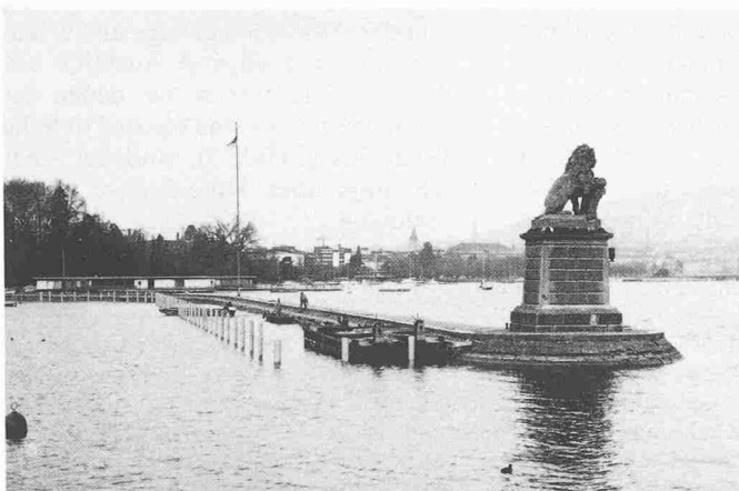
Bild 2. Hafenanlage mit geschlossener Mole, Zürich
