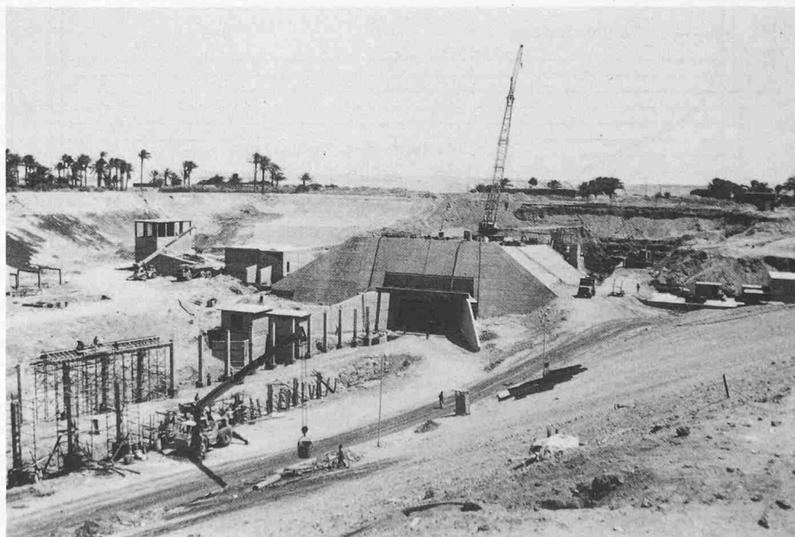
Bild 6. Westportal mit Lüftungsbauwerk
