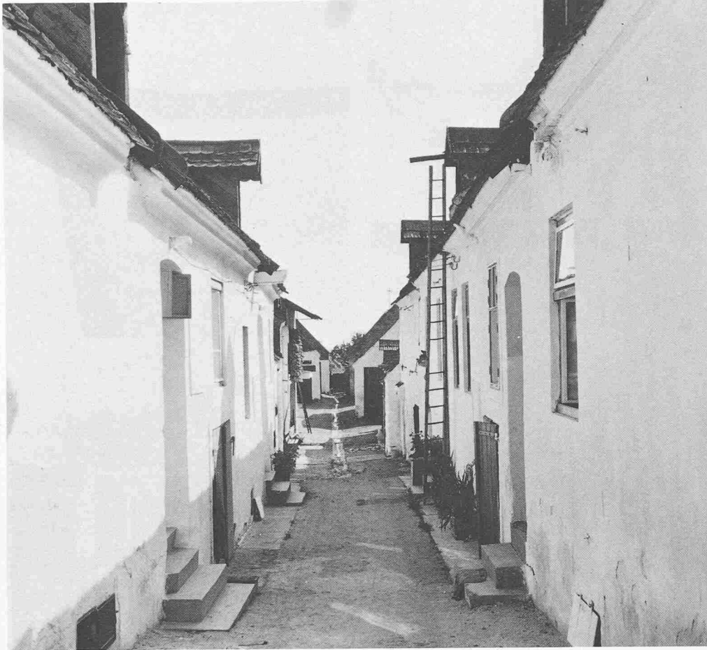
Hofgasse in Osip. Schmale Gassen und Höfe zwischen niedrigen Häusern – ein menschliches Mass.
