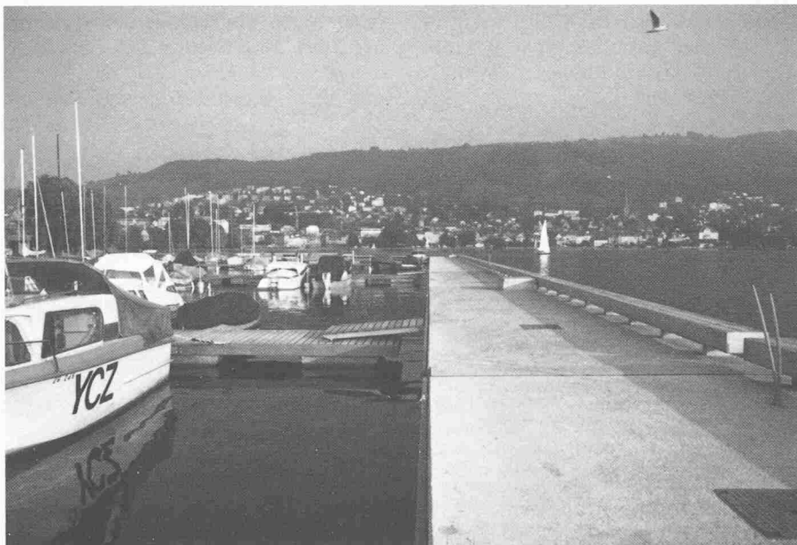
Hafenanlage in Zug, Mole 4 m breit
