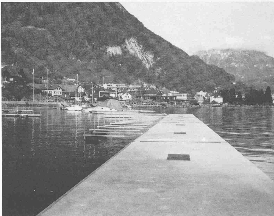
Hafenanlage in Gersau, Mole 4 m breit
