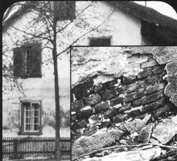
Renescan-Injektionen gegen aufsteigende Feuchtigkeit
