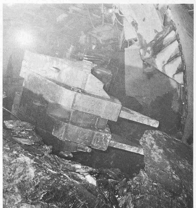
Bild 9. Reisszahnbagger Los Huttegg
