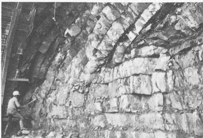
Bild 11. Vortrieb im Altdorfer Sandstein Los Büel
