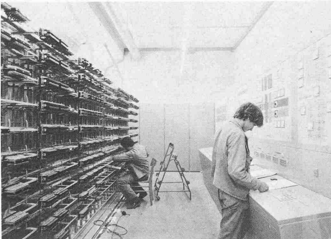
Bild 22. Montagearbeiten im Kommandoraum der Lüftungszentrale Huttegg
