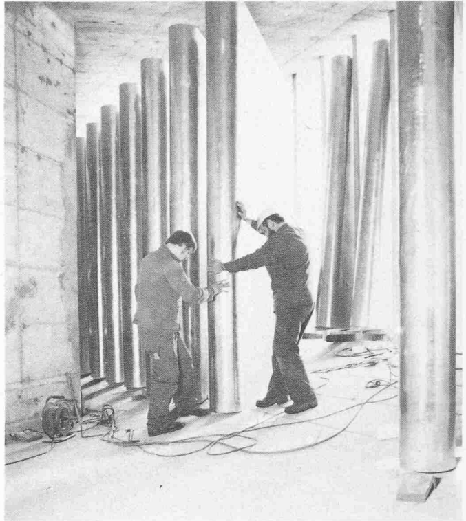
Bild 5. Montage der Kulissen-Schalldämpfer beim Abluftbauwerk Rütelen
