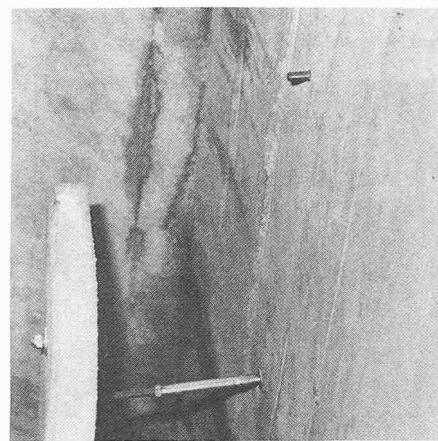
Bild 3. Verkleidungsplatten. Die Tunnelverkleidung aus vorfabrizierten Betonelementen wurde unten abgestellt und oben dann mit zwei speziellen Halteplatten und Klebeankern aus rostfreiem Stahl fixiert
