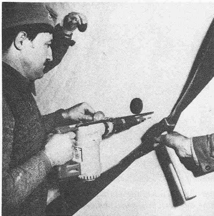
Bild 7. Die Vliesunterlage wird mit einem Nagelgerät mit Spezialstandplatte befestigt
