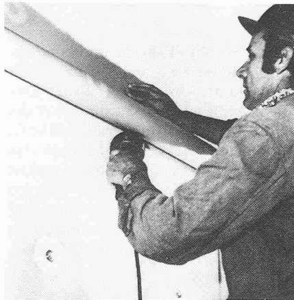
Bild 10. Die Folie wird mit Heissluft auf den PVC-Teller geschweisst
