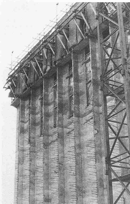
Anschluss-Seite zweite Bauetappe mit Zellenwandanschlüssen
